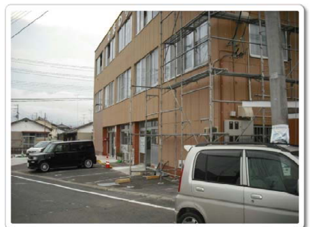
改修中のドリーム・ゲートのある建物
