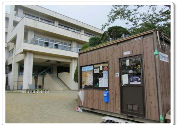
女川第二小学校校庭の局舎
